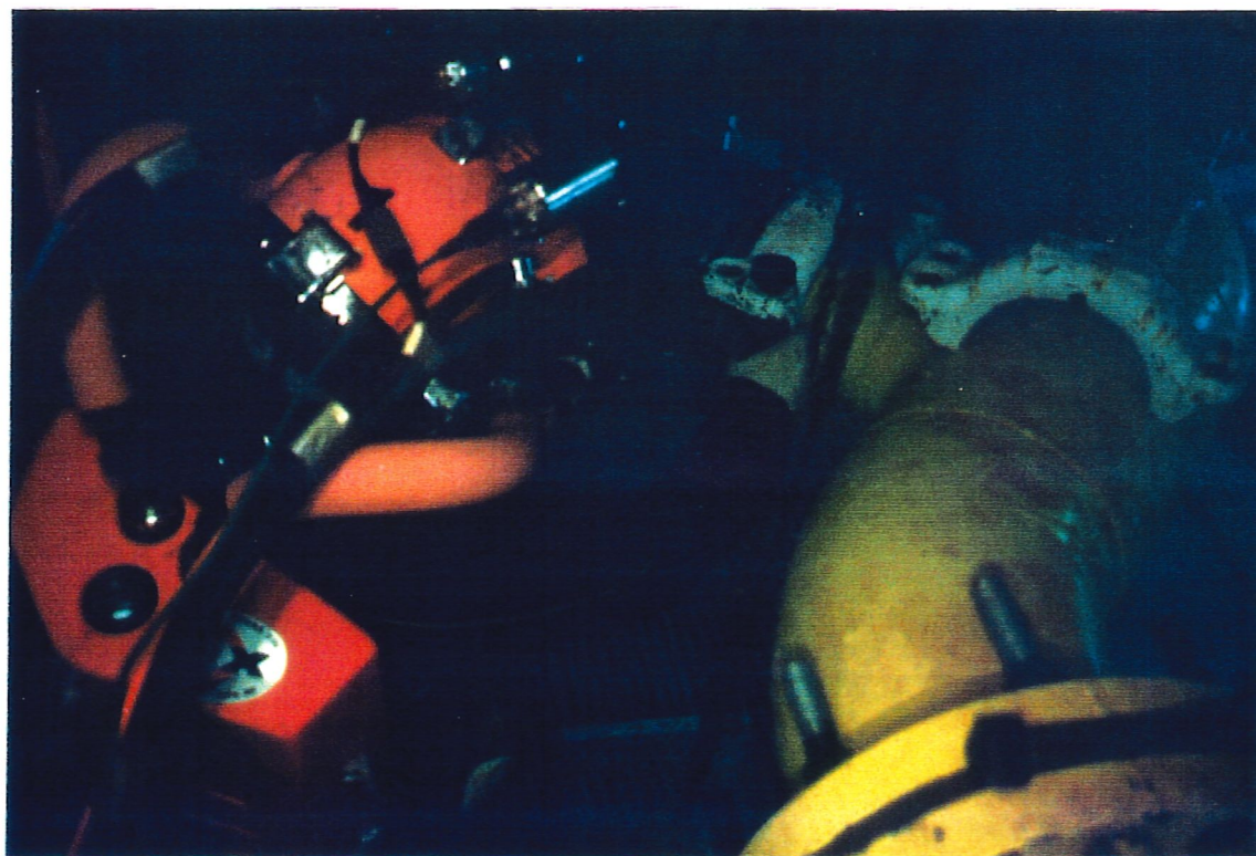
Connexion du pipe COFLEXIP COFLEXIP connection
