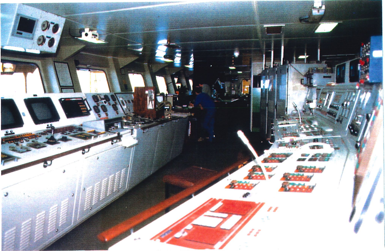
DSV ORELIA - Passerelle DSV ORELIA - Bridge O.C.C.
