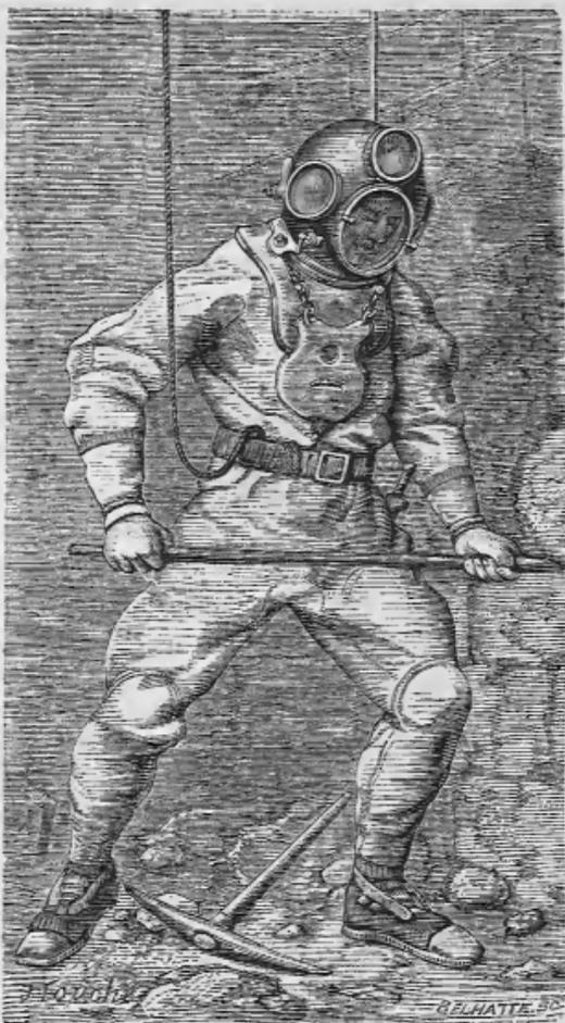
Fig. 7. — Scaphandrier pourvu du régulateur Denayrouze, costume complet.
