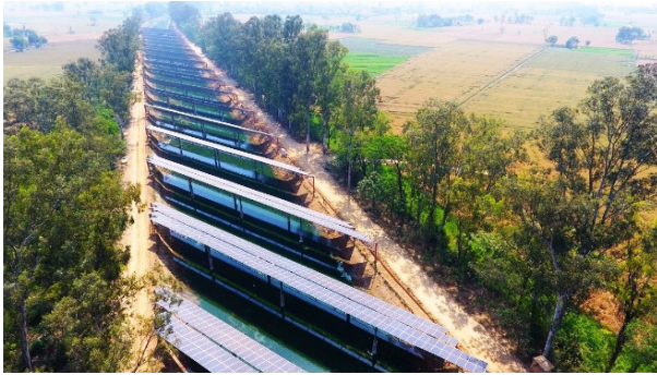
Fig. 4. Canal top solar systems 53)
