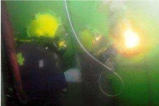
Photo n° 81: Diver using the Kerie cable (158)
