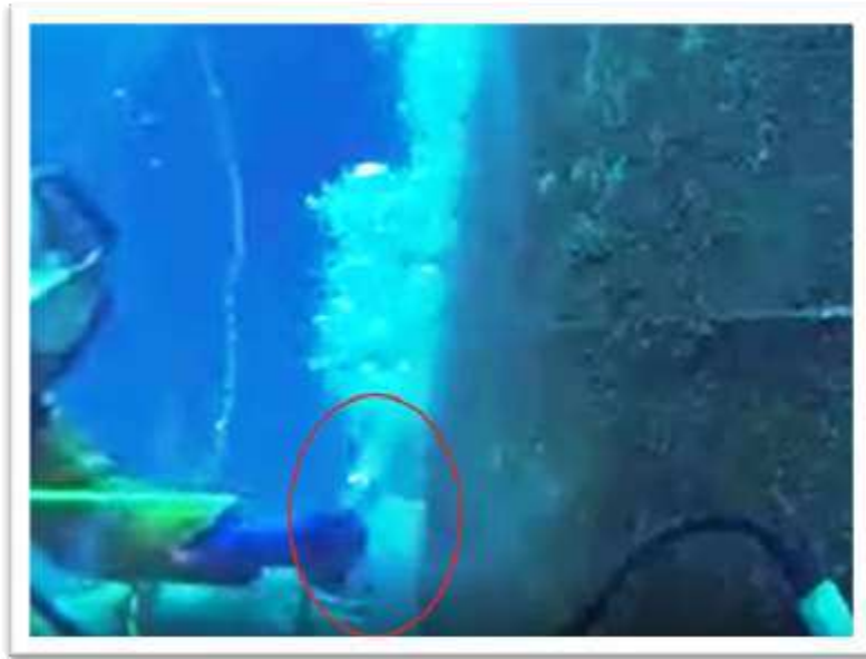
Fig. n°60: Smooth cut flushing (81).
